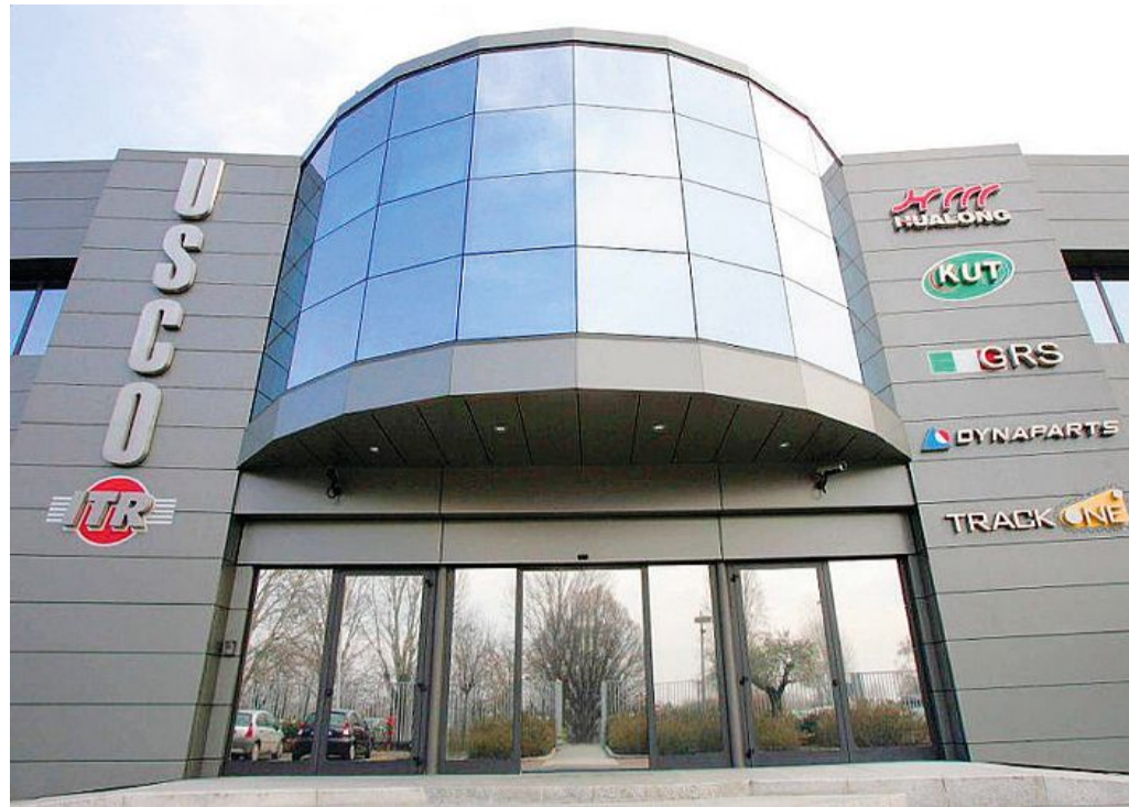
L'ingresso della sede principale dell'azienda Usco, che si trova a Modena in viale delle Nazioni
